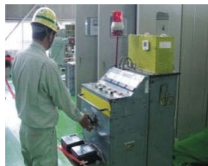
高圧盤検査作業
