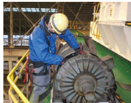
クレーン点検・修理
