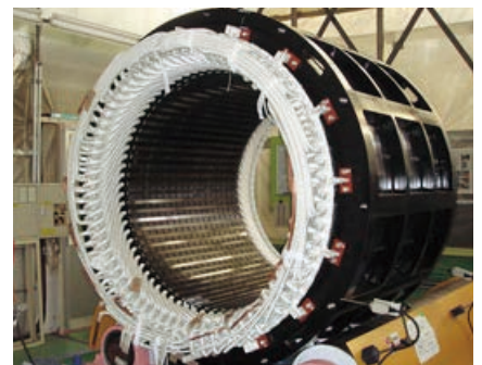
固定子の組立・分解修理作業
