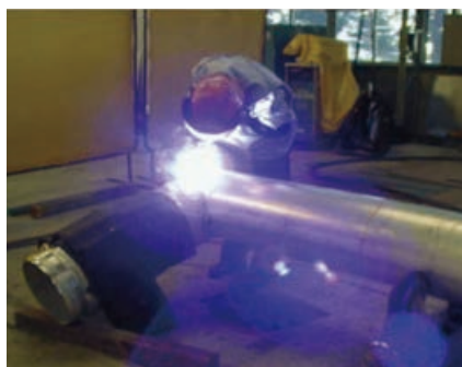
分岐シース溶接作業
