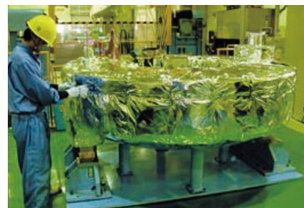
断熱用SI (スーパーインシュレーター) 貼付け作業
