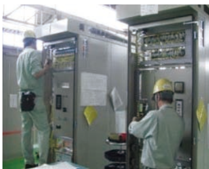
高圧盤組立作業
