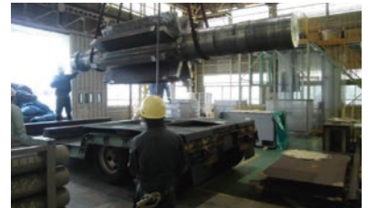
クレーン作業
